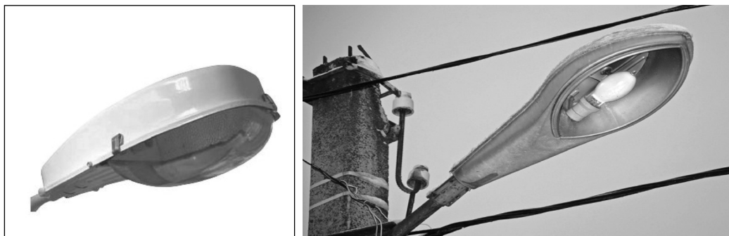
Рисунок 5. Внешние осветительные приборы (светильники), оснащенные лампами с электрическим разрядом в парах металлов
