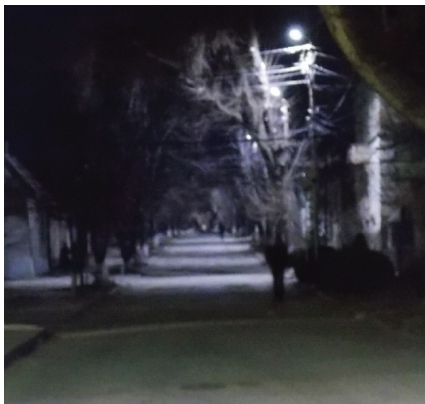
Figura 16. „Golurile” de iluminare la deconectarea lămpilor peste un pilon
